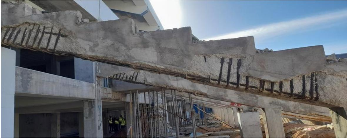
شكل 1.. كمرة بطول 5 متر تعرضت لانهيار الغطاء الخرساني وفقد جزء من مساحة مقطع حديد التسليح (المصدر المؤلفين)
